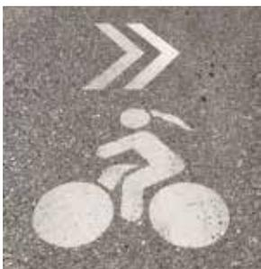
„Sharrow“ ist eine Wortkombination aus „share“ (teilen) und „arrow“ (Pfeil). Diese Piktogramme sind als Bodenmarkierung auf der Fahrbahn aufgebracht. Sie dienen einerseits dazu, Radfahrende im Straßenraum besser sichtbar zu machen und dadurch andere Fahrzeuge auf das Teilen der Fahrbahn hinzuweisen. Andererseits übernehmen die Symbole auch die Funktion der Wegweisung im Verlauf von Radrouten.
